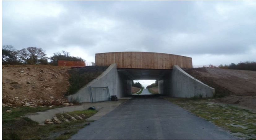
Exemple d'ouvrage de rétablissement par passage inférieur
