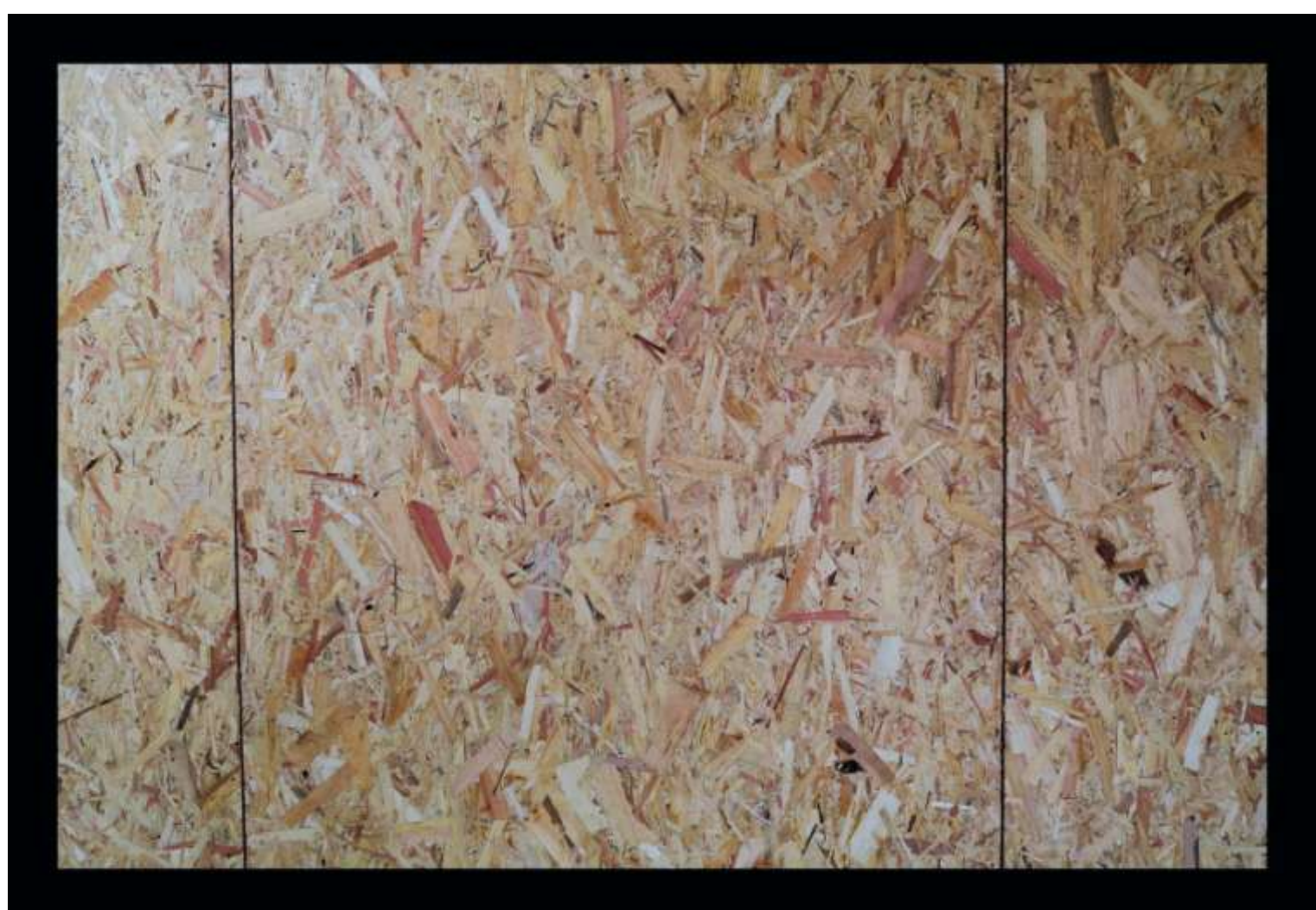
Certains panneaux en OSB resteront apparents
