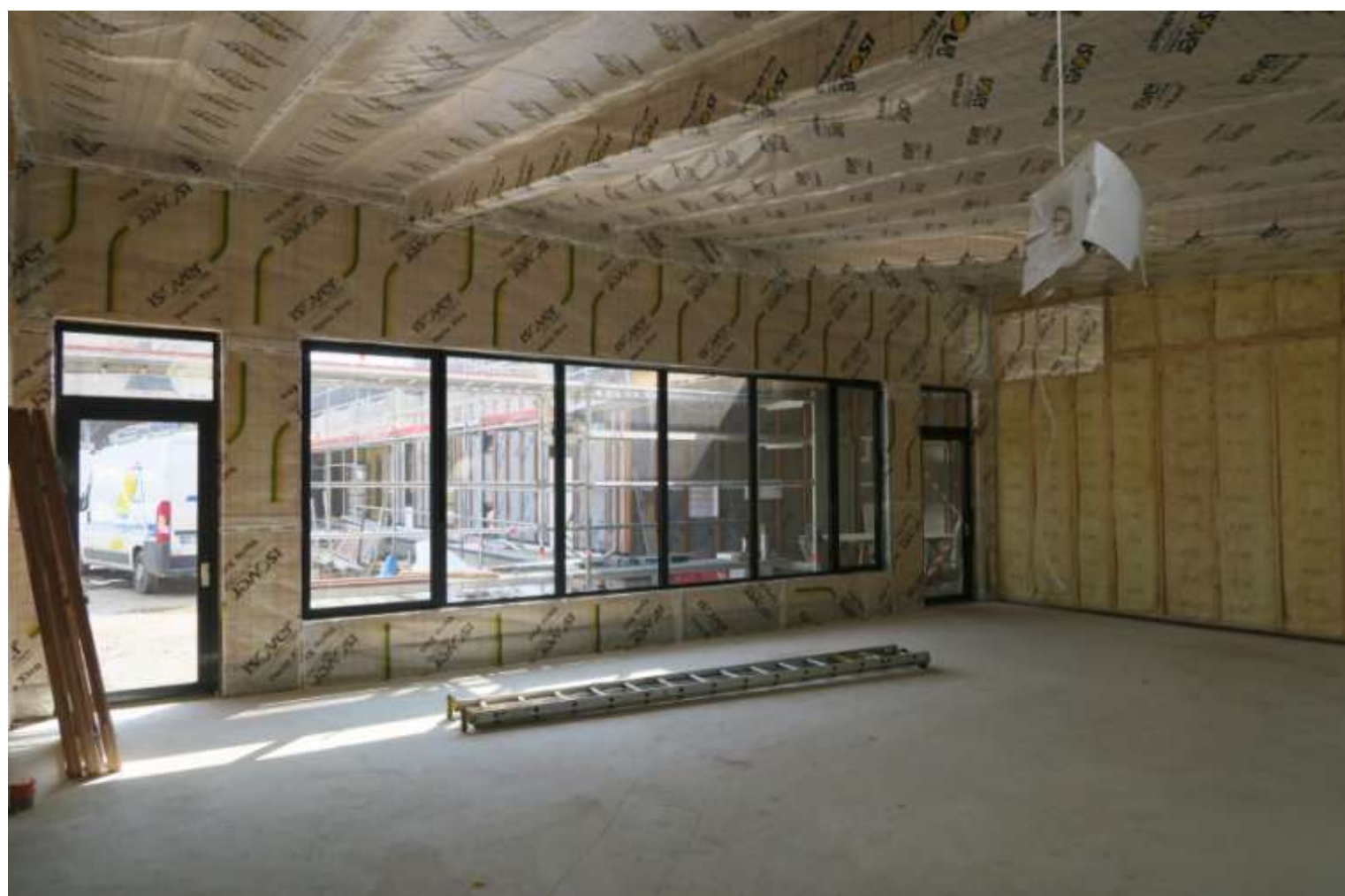
L'intérieur du futur local de restauration
