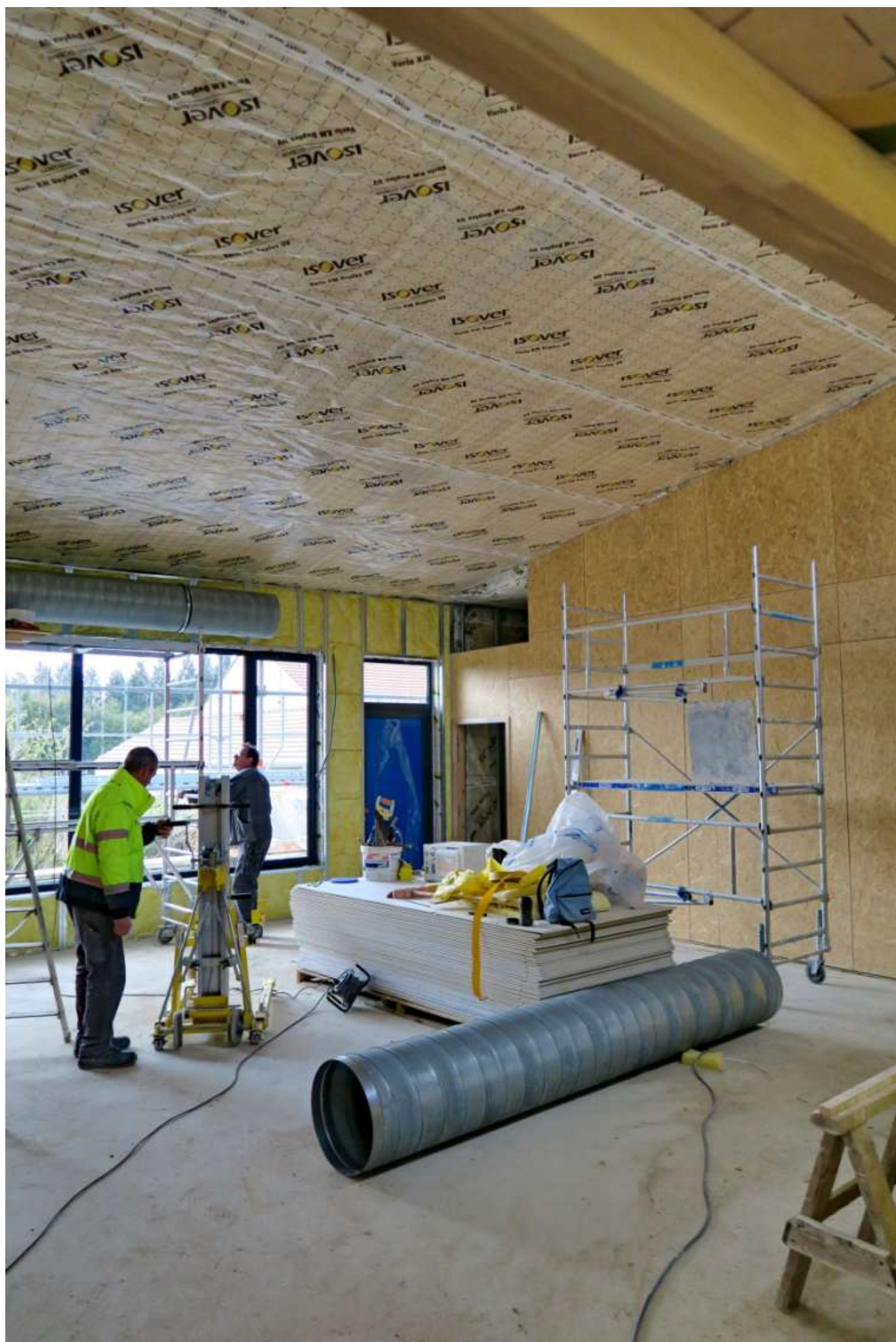
Le montage des gaines de ventilation.
